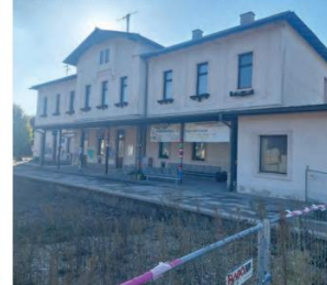
Bahnhofsbauwerk (Bestand) Nord
