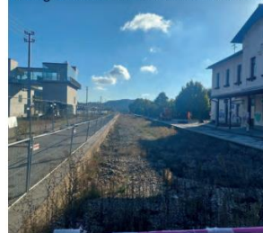
Zugang zu den Bahngleisen
