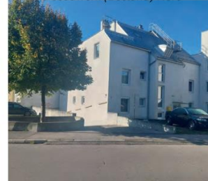
Zufahrt Tiefgarage - Anrainer
