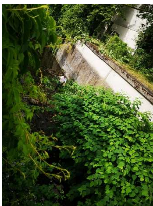
Einsatz im/am Gablitzbach beim Pfarrhof
