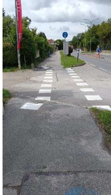
Neue Markierung Einfahrt Dambach
